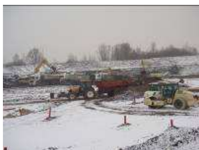
Terrassement, VRD, assainissement pour l'installation de l'usine Flamoval à Arques
