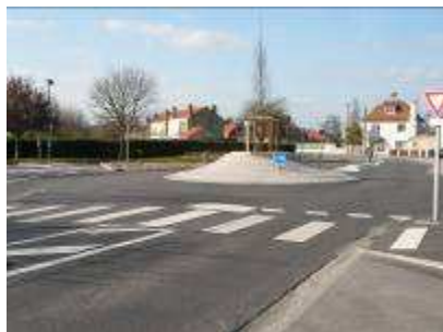
Aménagement de giratoires, assainissement, VRD pour la Communauté urbaine de Dunkerque
